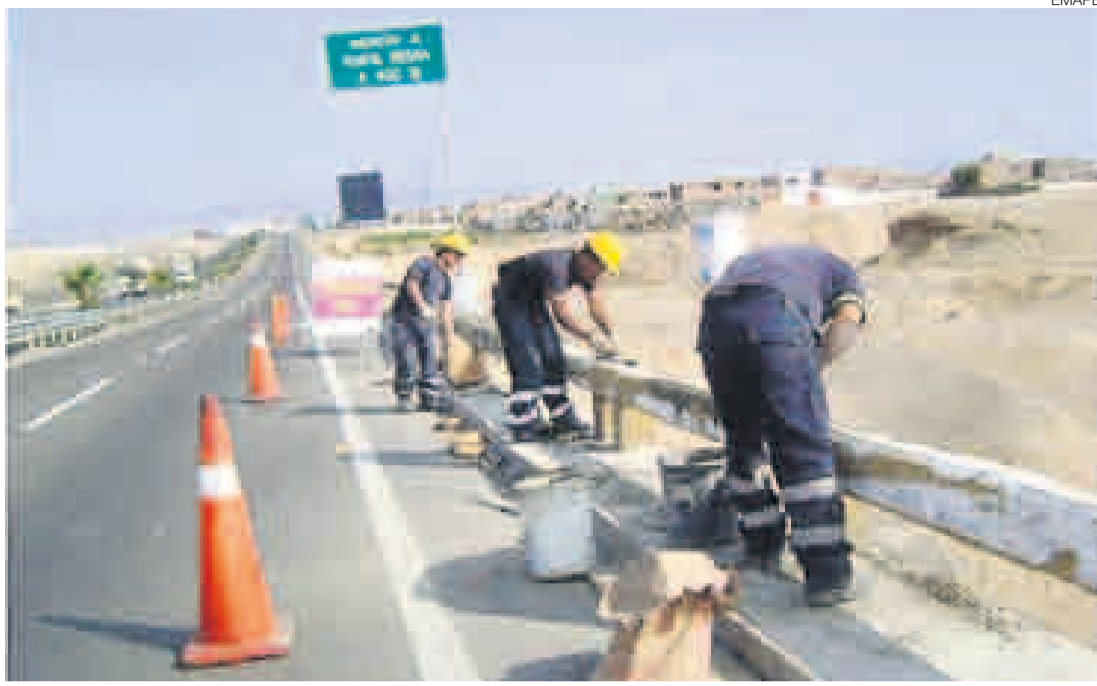
PARA EL VERANO. Las barandas, veredas y sardineles estaban en mal estado. También arreglarán pistas.
