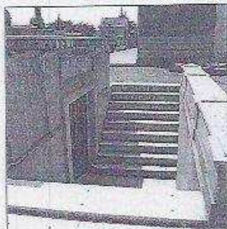
VISTA DEL ACCESO AL SOTANO
