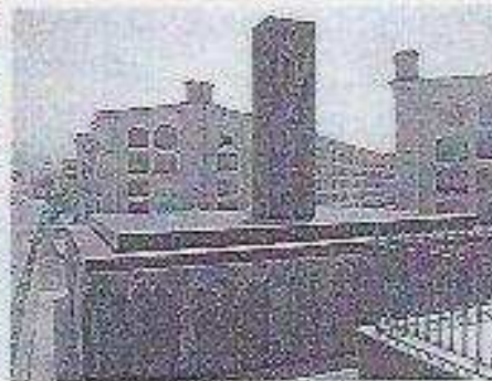
VISTA LATERAL DERECHO
